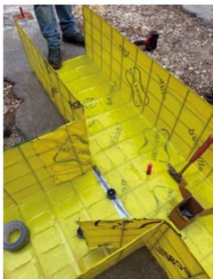
Bauseitige Verbindung der ab Werk vorkonfektionierten, u-förmig gebogenen Fundamentalschalung
