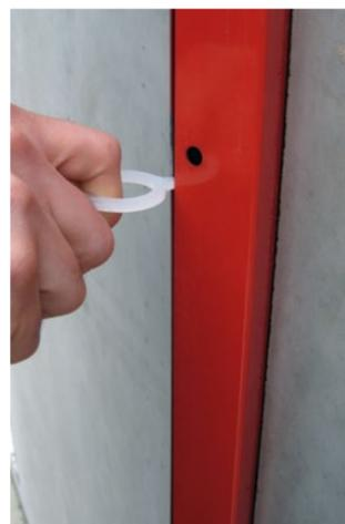
Nach dem Betonieren wird der Anker abgedreht, und die Schiene kann wiederverwendet werden.
