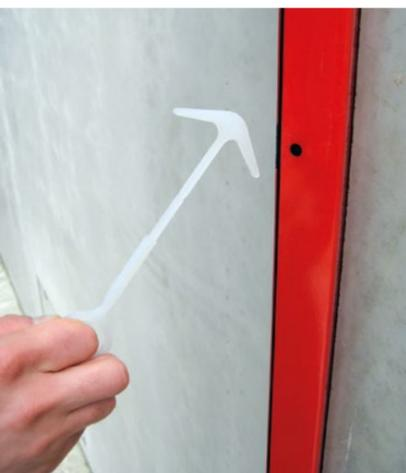
Das Flex-Stahlprofil wird mit einem Arretierungsanker im Plattenstoß verspannt.
